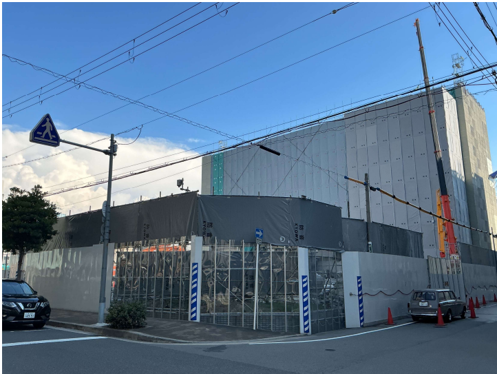
現場全景 (北西より南東を望む)
