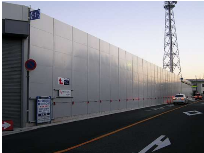
遮音性を有する「防音壁」を 北面、西面に設置
