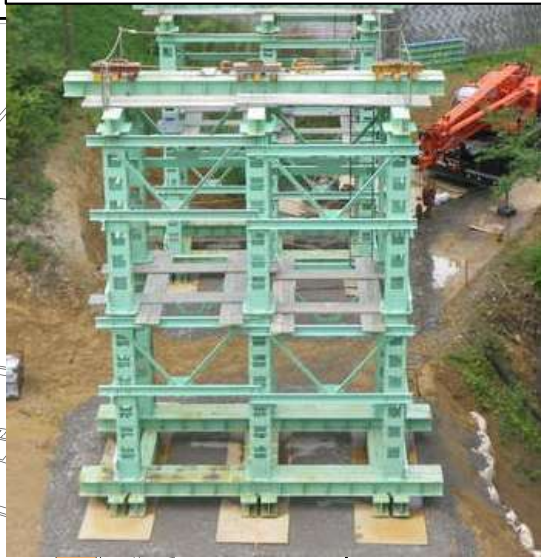
仮設備（鋼製の受け台）*イメージ
