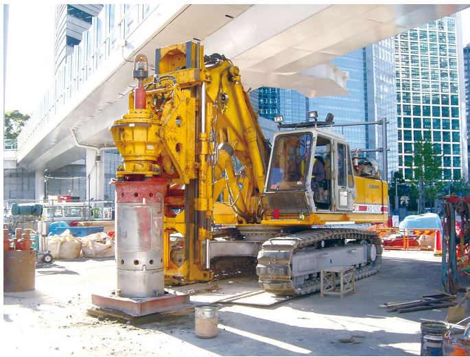
大口径削孔機
