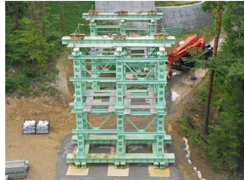
鋼製ベント (鋼製の受け台)
