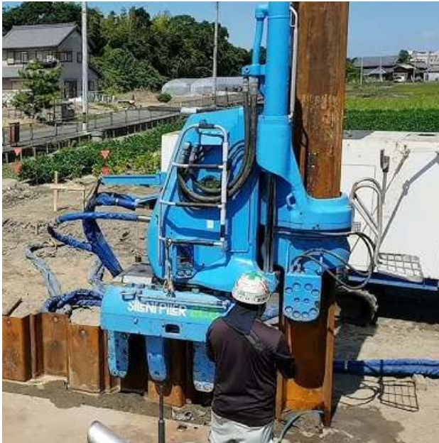
杭打機 (鋼矢板)
