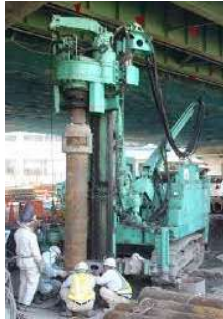
回転鋼管杭圧入引抜機
