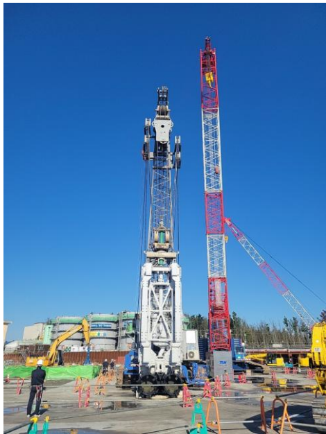
仮土留め掘削機
